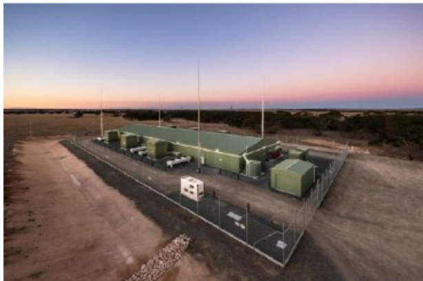
Рис. 1. Управляемая система накопления энергии мощностью 30 МВАр (а) и синхронный компенсатор с маховиком мощностью 250 МВАр (б)
